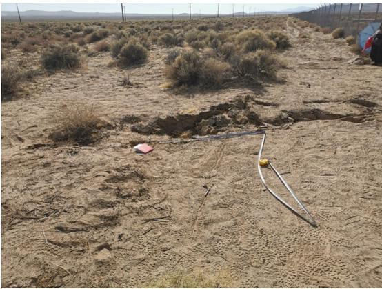
M7.1级地震地表破裂破坏海军军事基地围栏巡查公路
